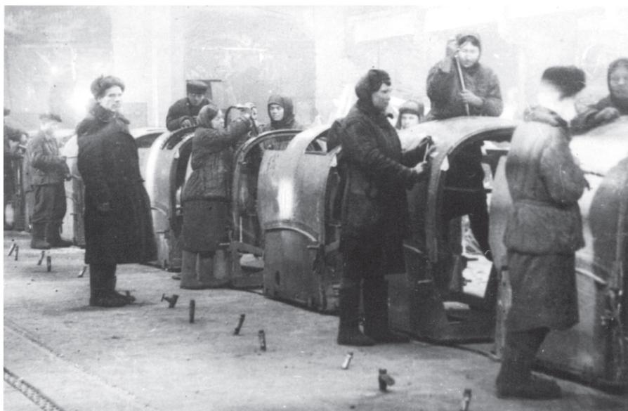
*Поточно-конвейерная сборка бронекабин*
