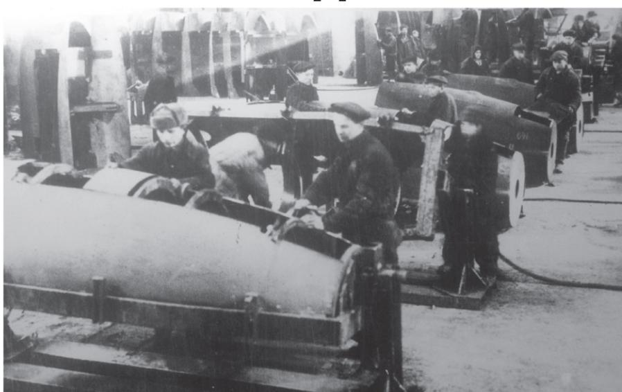
Поточная сборка капота самолета-штурмовика Ил-2
